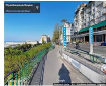
Photo 13 : av. Benjamen-Constant, vue depuis au-dessus de la promenade Derrière-Bourg
